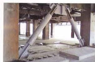
座屈拘束ブレース(履歴系) Buckling restraining brace (hydraulic system)
