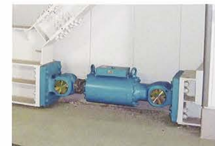
オイルダンパー（粘性系） Oil damper (viscous)
