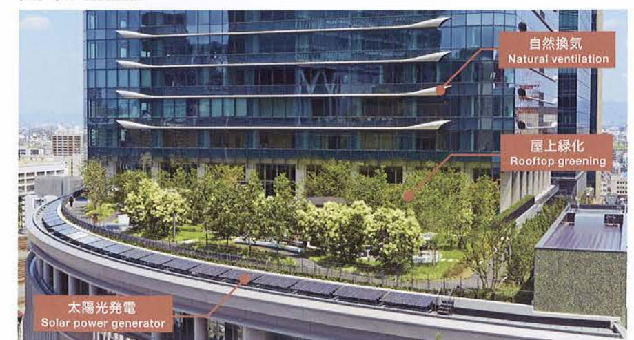
南館テラスガーデン South Terrace garden
