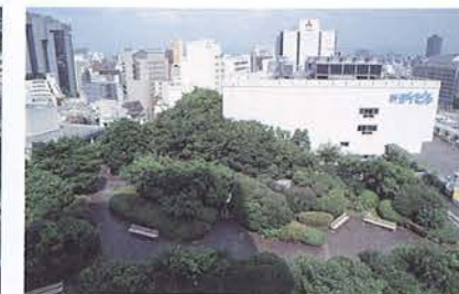
旧・新ダイビル屋上樹苑(約1,000坪)
