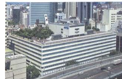
旧・新ダイビル外観
