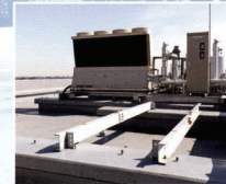
屋上機器設置スペース
