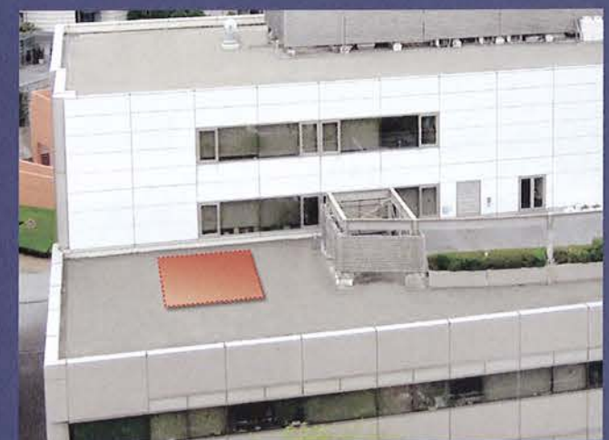
非常用自家発電機設置予定エリア(4階部分)
