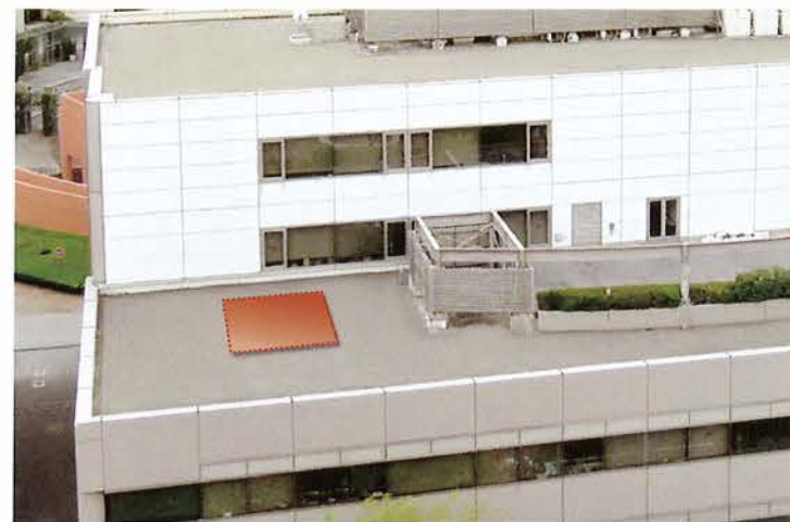
非常用自家発電機設置予定エリア(4階部分)
