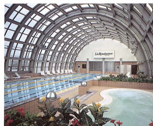
開閉自在の屋根を持つプール(プラザ6階)
