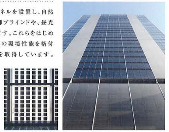
太陽光発電パネル Solar panels
