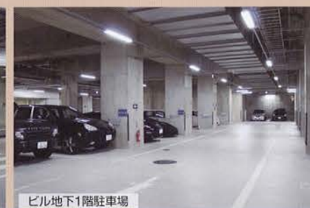
ビル地下1階駐車場
