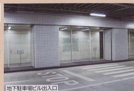
地下駐車場ビル出入口
