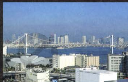
北東方面のレインボーブリッジ、スカイツリーを望む Looking towards Rainbow Bridge to the northeast, and Skytree
