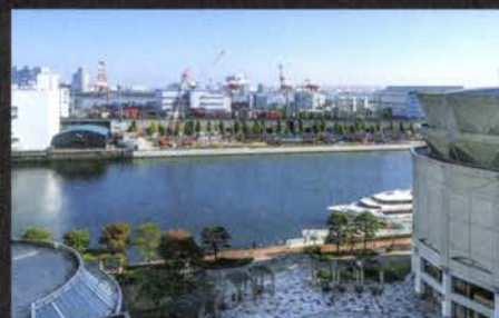
南東方面のセンターコートと水辺を望む Looking towards the center court and waterside towards the southeast
