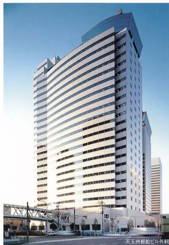
天王洲郵船ビル外観
