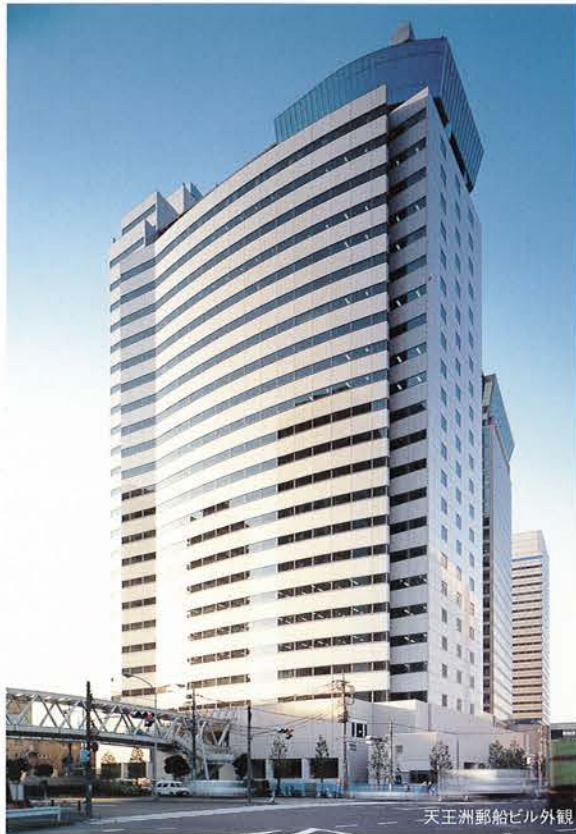
天王洲郵船ビル外観
