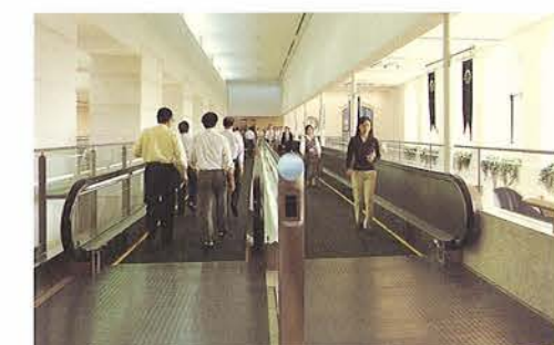
ウエストタワーとイーストタワーを結ぶ“ムービングウォーク” “Moving walkway” connecting the West and East Towers
