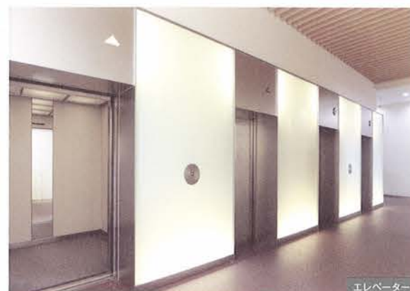
エレベーター
