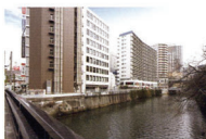
目黒川とビル外観
