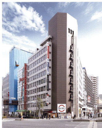
外観 ※掲載の写真は平成31年2月に撮影したものです。
