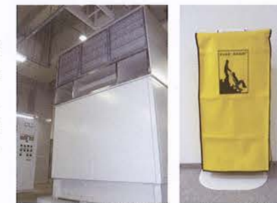
非常用発電機
