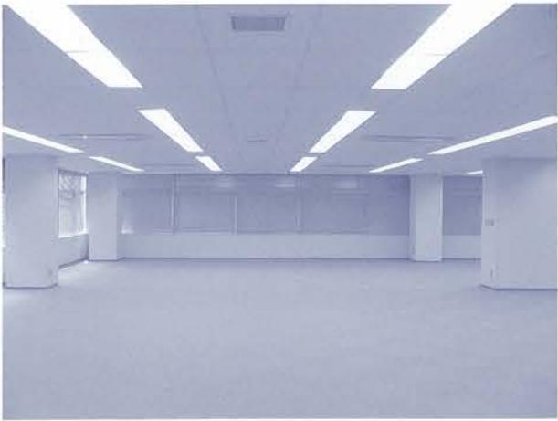
タイルカーペット敷きの床はOAフロア
