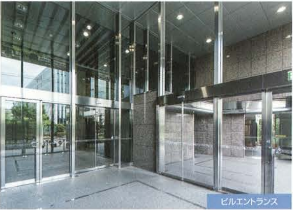
ビルエントランス
