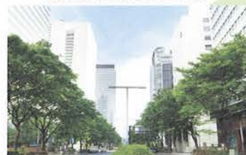
高層ビルが並ぶ広く整然とした並木道 ※右から2軒目が新宿サンエービル！
