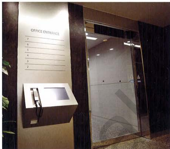
セキュリティに配慮したオートロックと受付案内システム。
