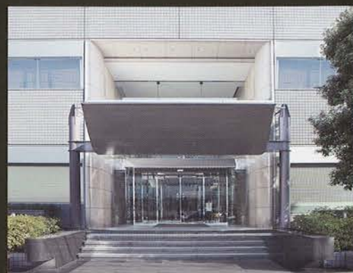
旧海岸通りに面した視認性に優れたエントランス
