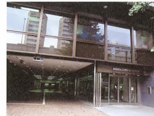
1Fメインエントランス Ground Entrance
