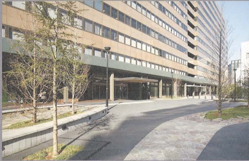
ビル外構 (2007年リニューアル)
