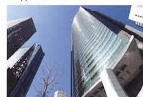
2 汐留シティセンター Shiodome City Center
