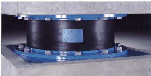
積層ゴム免震装置（参考写真）
