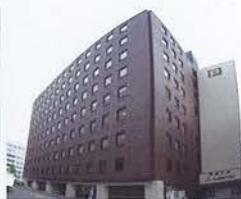
機械式立体駐車場併設
