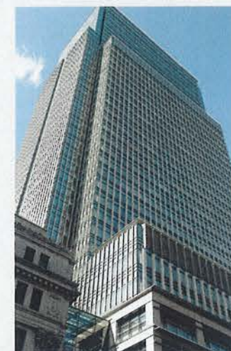
日本橋三井タワー
