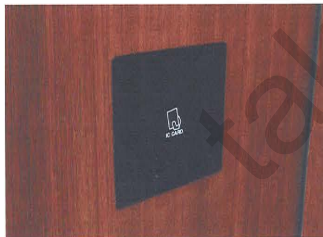
エレベーター内の非接触ICカードリーダー Proximity IC card provided inside elevator
