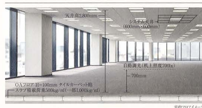
天井高2.8mの無柱空間
