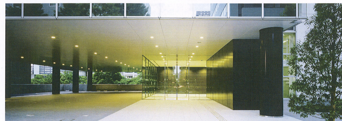
▲エントランス外観
